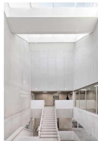
Treppenhaus und Luftraum ↑
